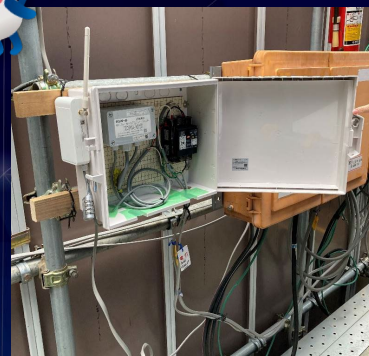
仮設盤業者にて IoTブレーカを設置
