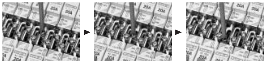
切替金具の接続ねじを緩める。
