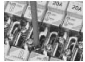
切替金具の接続ねじを締め付けて200Vへの切替え完了です。
