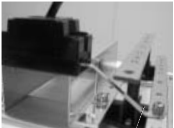
安全ブレーカ 200V切替バー (ULFSB302L)
