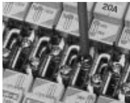
切替金具の接続ねじを緩める。
