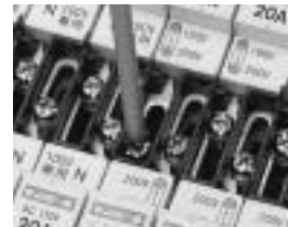
切替金具の接続ねじを締め付けて200Vへの切替え完了です。
