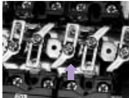
切替金具の接続ねじを緩める。
