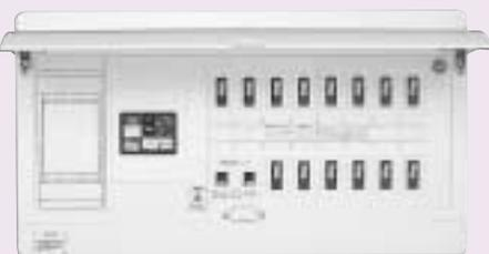
電源線、アース線から侵入する誘導雷サージから家庭内の機器を保護します。避雷器の動作確認ランプ(通常時点灯、異常時消灯)で正常動作が目視確認できます。
